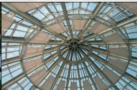
ESTORES DE CRISTALERAS
